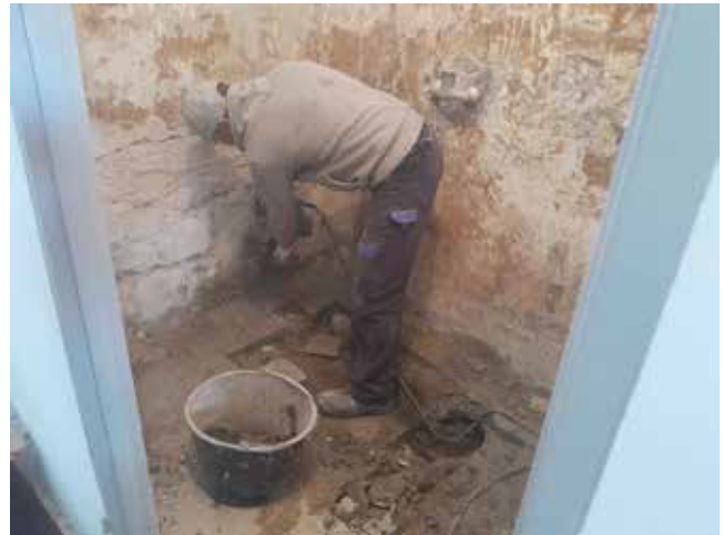
Porządki gminne - roboty budowlane na stadionie miejskim, skuwanie płytek w jednym z pomieszczeń natrysków
