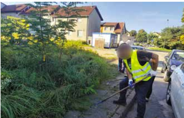
Hakanie krawężników - ul. Zielona, plac manewrowy
